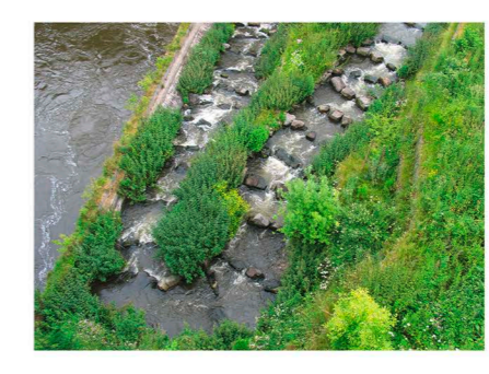
Fish ladders in Mühlheim-Raffelberg (top) and Haslingen (right) enable fish migration. Fischschotterge Mühleim-Raffelberg (oben) und Haslingen (rechts) ermöglichen die Fischwanderung.
