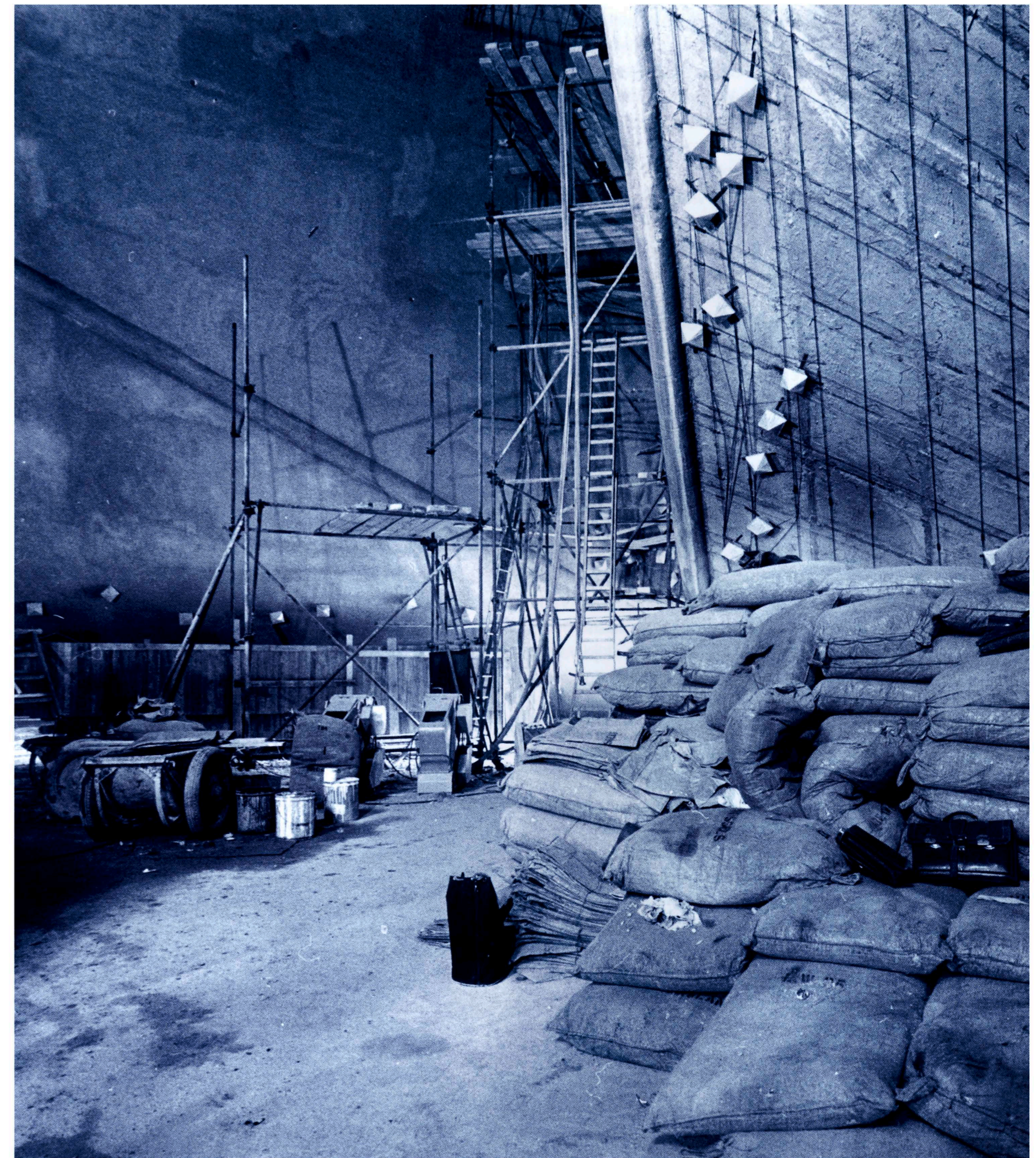
Philips-paviljoen in aanbouw, binnenzijde | Foto Hans de Boer.
